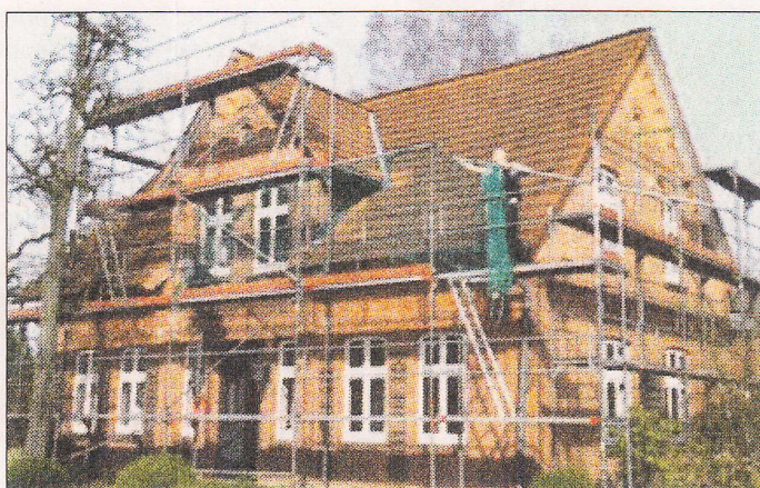
Dieses Backsteingebäude an der Harburger Straße in Hanstedt wird zurzeit zum Atelier umgebaut. Foto: po
